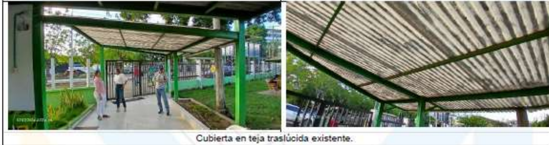
Cubierta en teja traslúcida existente.
